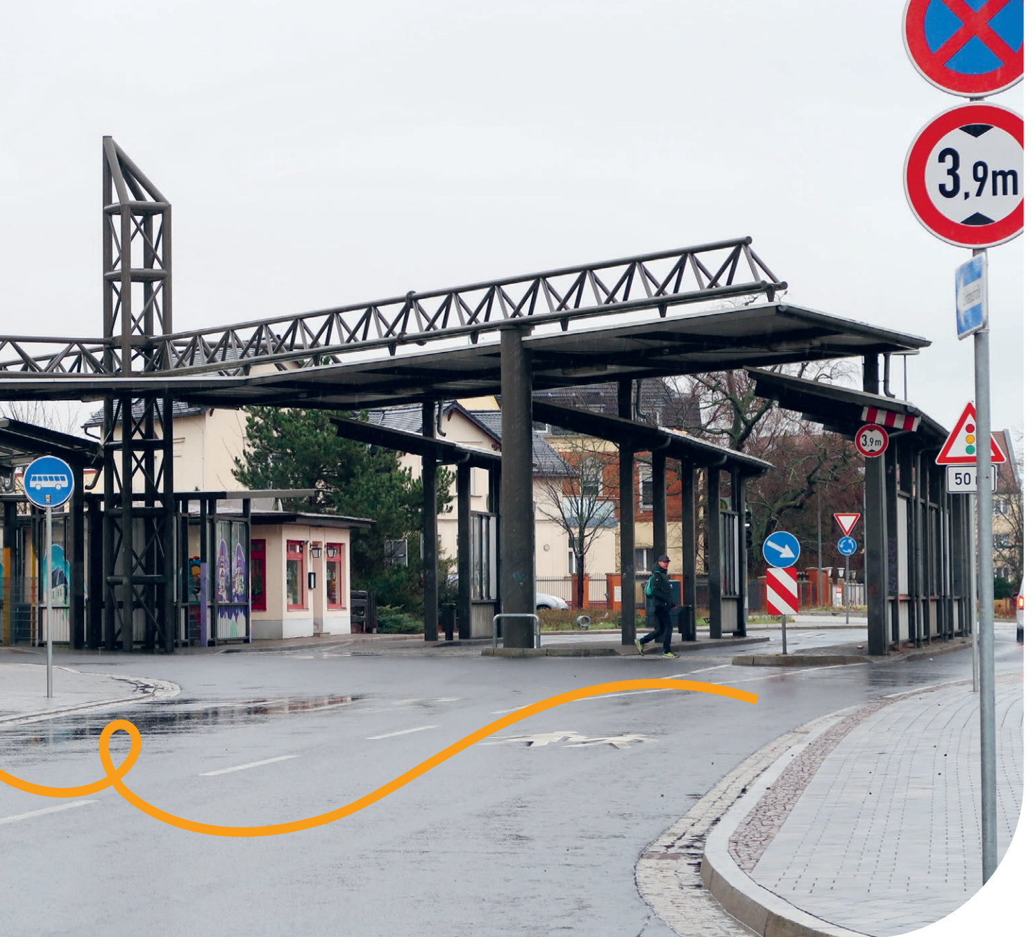
Eine wichtige Station der gemeinsamen Vor-Ort-Begehung: Der Busbahnhof in Wurzen.
